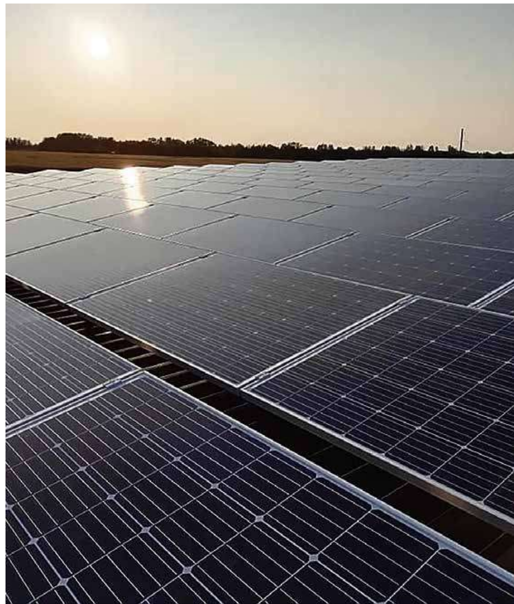
Jamso Teenused rajab päikeseelektrijaamu mitmesugustele katustele ja fassaadidele ning maapaigaldistena.
